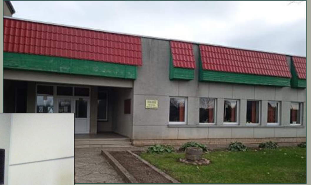
Apskardintas Nairių kultūros namų stogas.
