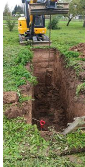
Rinkūnų Parko g. lietaus kanalizacijos remontas
