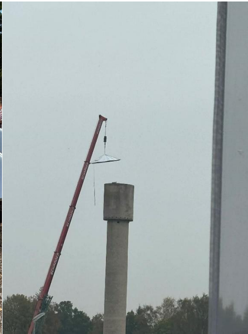
Buvusio Pumpėnų vandens bokšto stogo remontas
