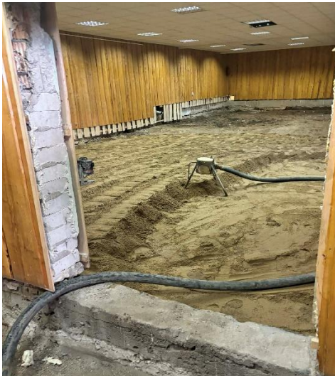
Pumpėnų kultūros namų grindų betonavimo ir šildomų grindų įrengimo darbai
