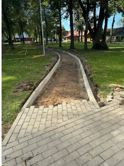
Takelio įrengimo darbai Pumpėnų Ažuolyno a. skvere
